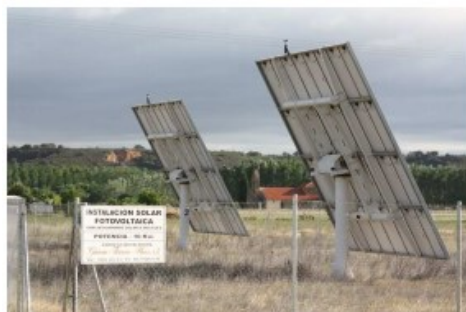
Placas solares orientables en Bercianos de Valverde
